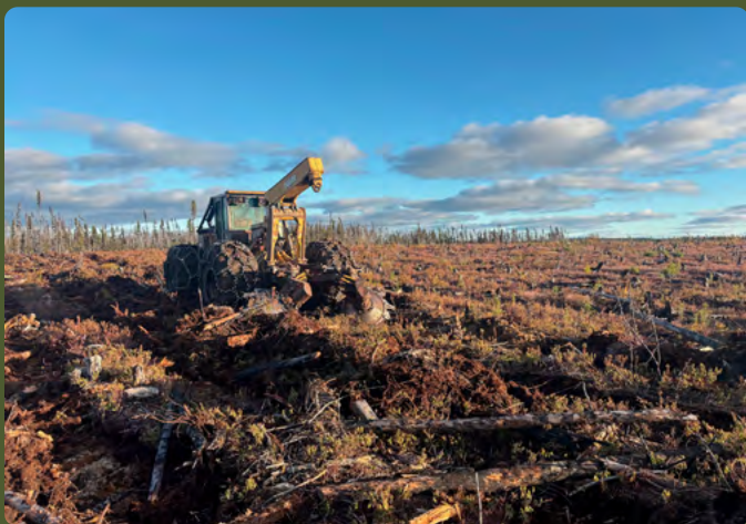
Préparation de terrain
